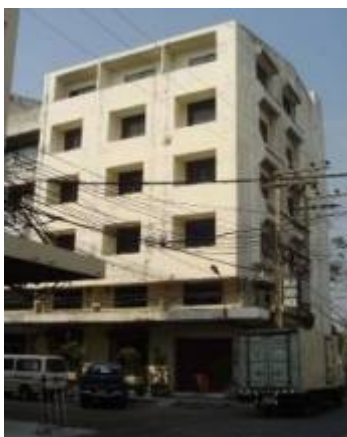
รูปที่ ค-5 ตัวอย่างโครงสร้างภายนอกอาคารของศูนย์กระจายสินค้าของโรงงาน
